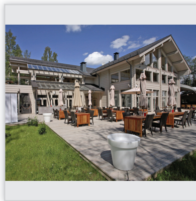
Budynek restauracyjny wraz z zapleczem kuchennym Powierzchnia: 350 m 2 . Ściany wykonane z bali klejonych grubości 204 mm.
